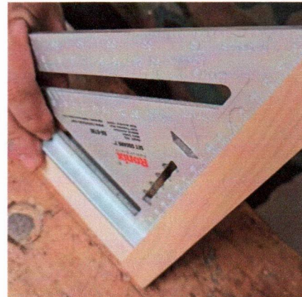
Fotografía 4: Fijación y armado de bastidor a 45°
